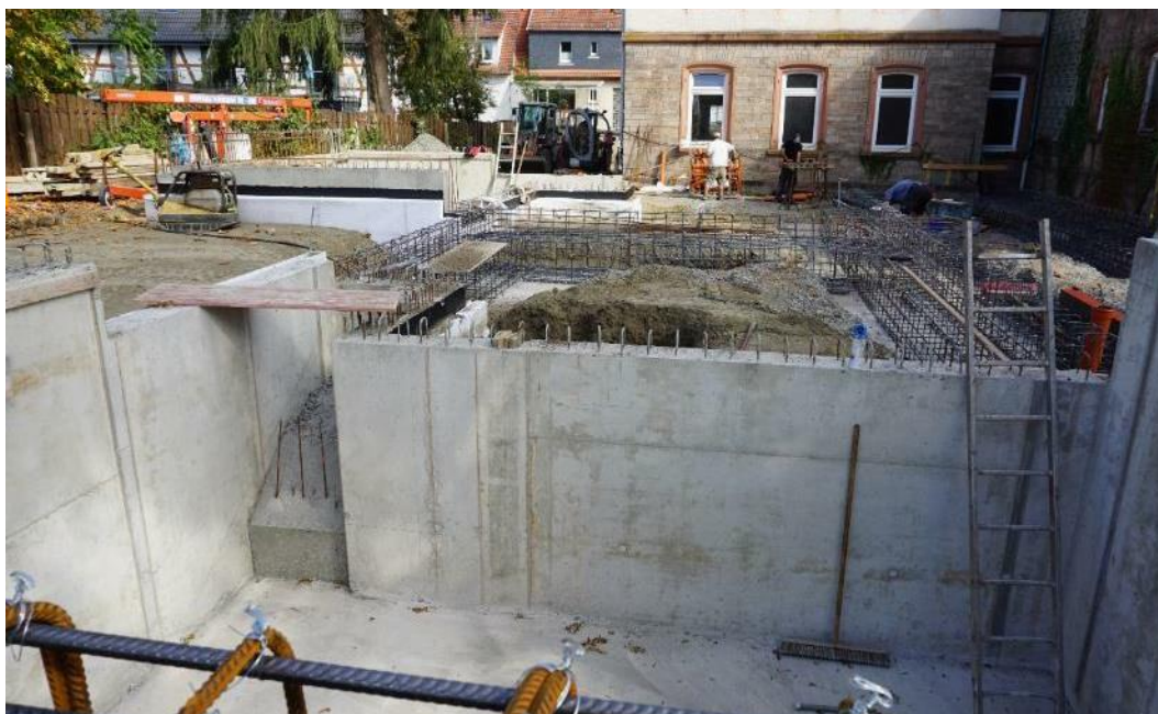
Fundament des Ergänzungsbaus
