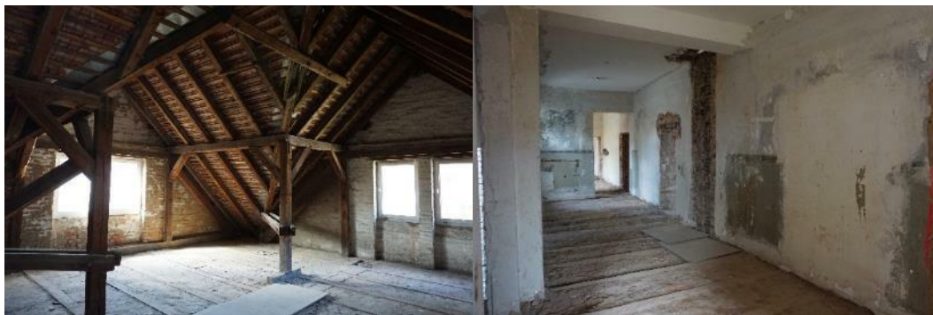
Ansichten des Dachstuhls und des 1. Obergeschosses nach Entkernung
