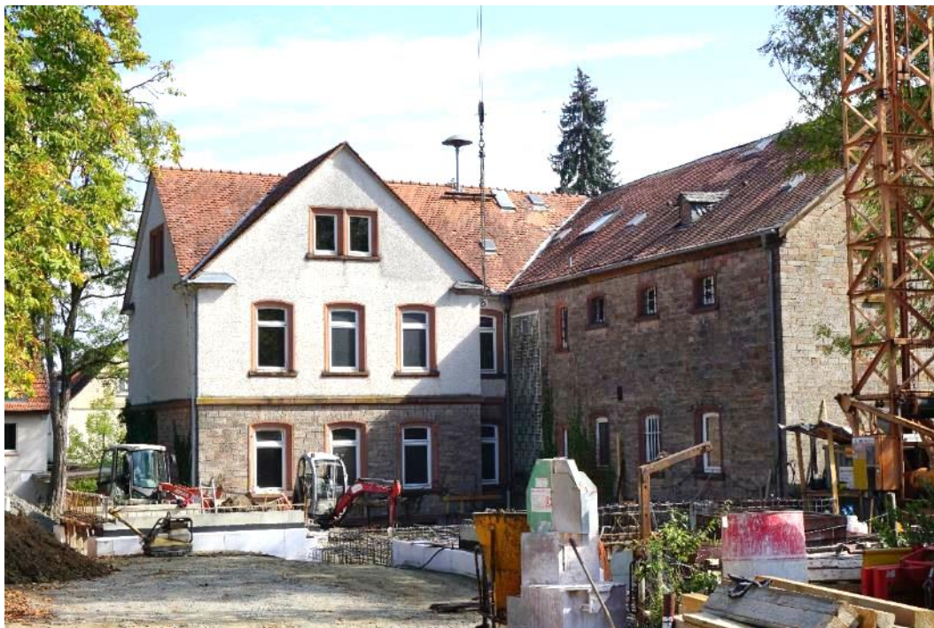
Altes Amtsgericht von Westen. Im Vordergrund Bauarbeiten für den Ergänzungsbau
