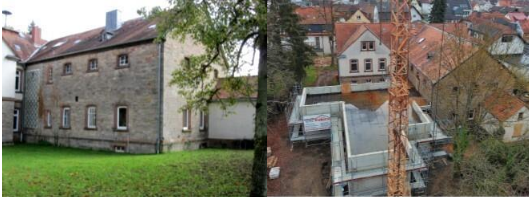
Abbildung 4: links alter Gefängnistrakt (Quelle: Rittmannsperger Architekten 2018); rechts: Decke des Anbaus / Terrasse ist gegossen. (Quelle: PANKRATZ + PARTNER | ARCHITEKTEN mbB, 2021)
