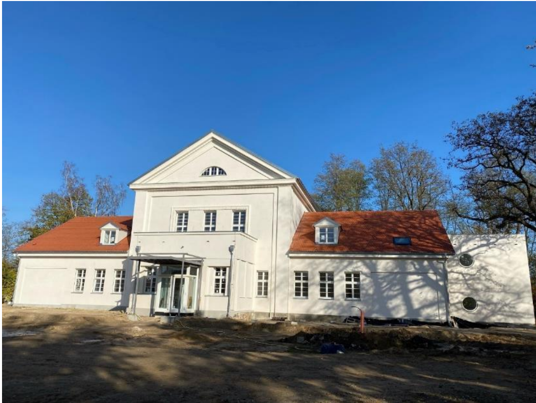
Abbildung 1: Gebäude heute ©Stadt Bad Belzig
